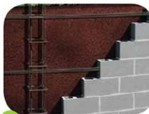
**3** Levantamento das paredes e aplicação do reboco liso.
