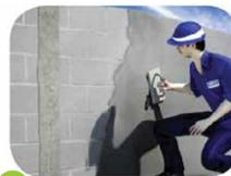
**4** No fundo usa-se concreto leve com vermiculita ou manta amortecedora.
